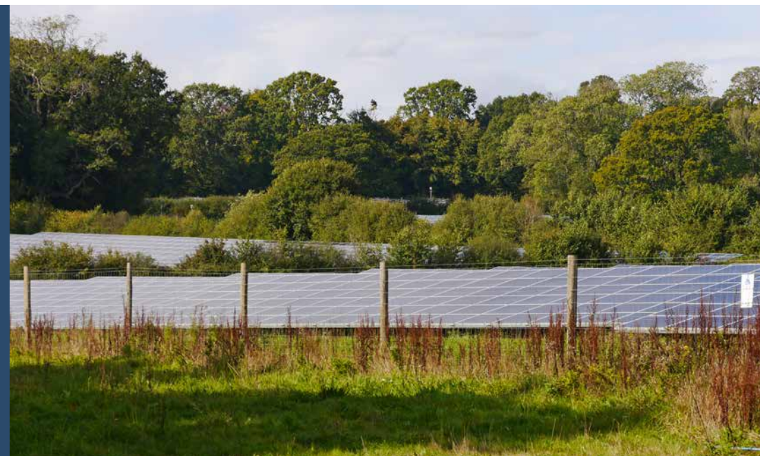
Foto 5. Southwick Estate Solar Farm (bij Portsmouth, Verenigd Koninkrijk). In dit landschapsinclusieve zonneveld zijn de grootte en de vorm van de velden met panelen aangepast aan het bestaande landschap, waardoor de beplantingsstructuren behouden blijven en de zichtbaarheid van de panelen minder groot is.
