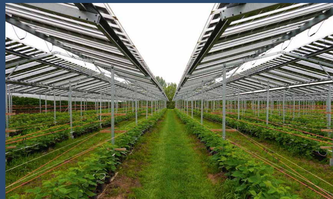
Foto 6. Agri-PV Babberich (Nederland) is een voorbeeld van een zonneveld met een gemengde productie. Semi-transparante zonnepanelen wekken elektriciteit op en laten voldoende licht door voor de frambozenteelt.
