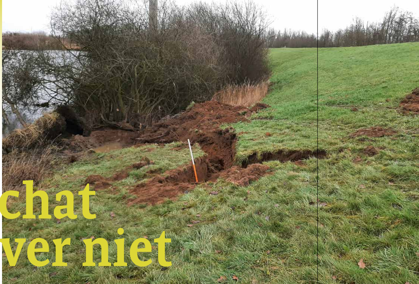
Een opengewerkte bevergang in een kering langs de Maas, januari 2022.
