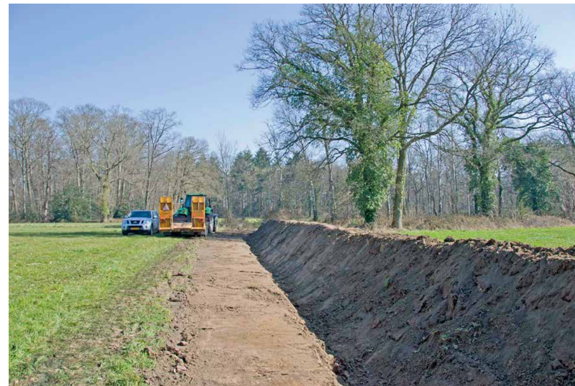
Aanleg nieuwe houtwal op landgoed Twickel.
